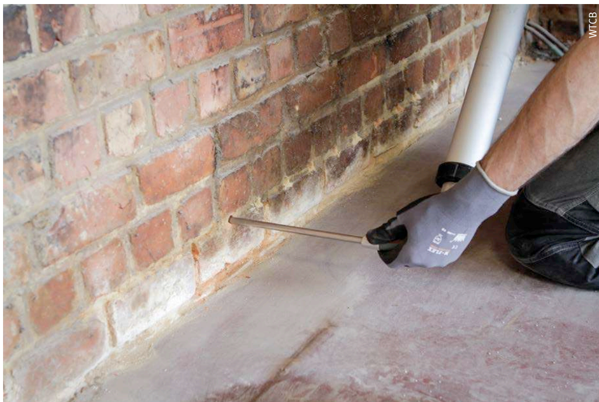
Afb. 5 Het waterkerende product wordt in de boorgaten geïnjecteerd die voorafgaandelijk met gelijke intervallen op een horizontale lijn in de mortel geboord werden.
